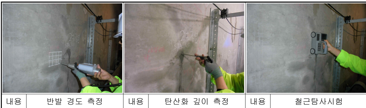
【사진 3.4】 문발SS인출 전력구 재료시험 전경
